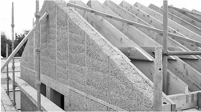
вычайно лёгким. Также он обладает и свойствами изоляции, благодаря чему расходы на отопление сокращаются практически в два раза. Материал дышащий, из-за чего происходит естественная
