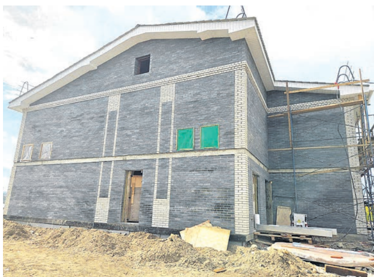
Здание насосной на Верхней Набережной почти готово.
