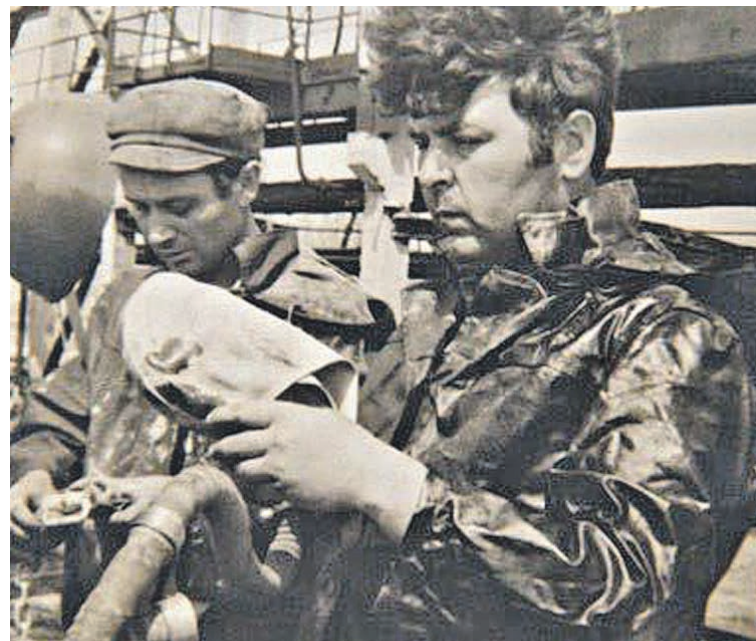
Иосиф Душанек на строительстве ПК «Шесхарис».
